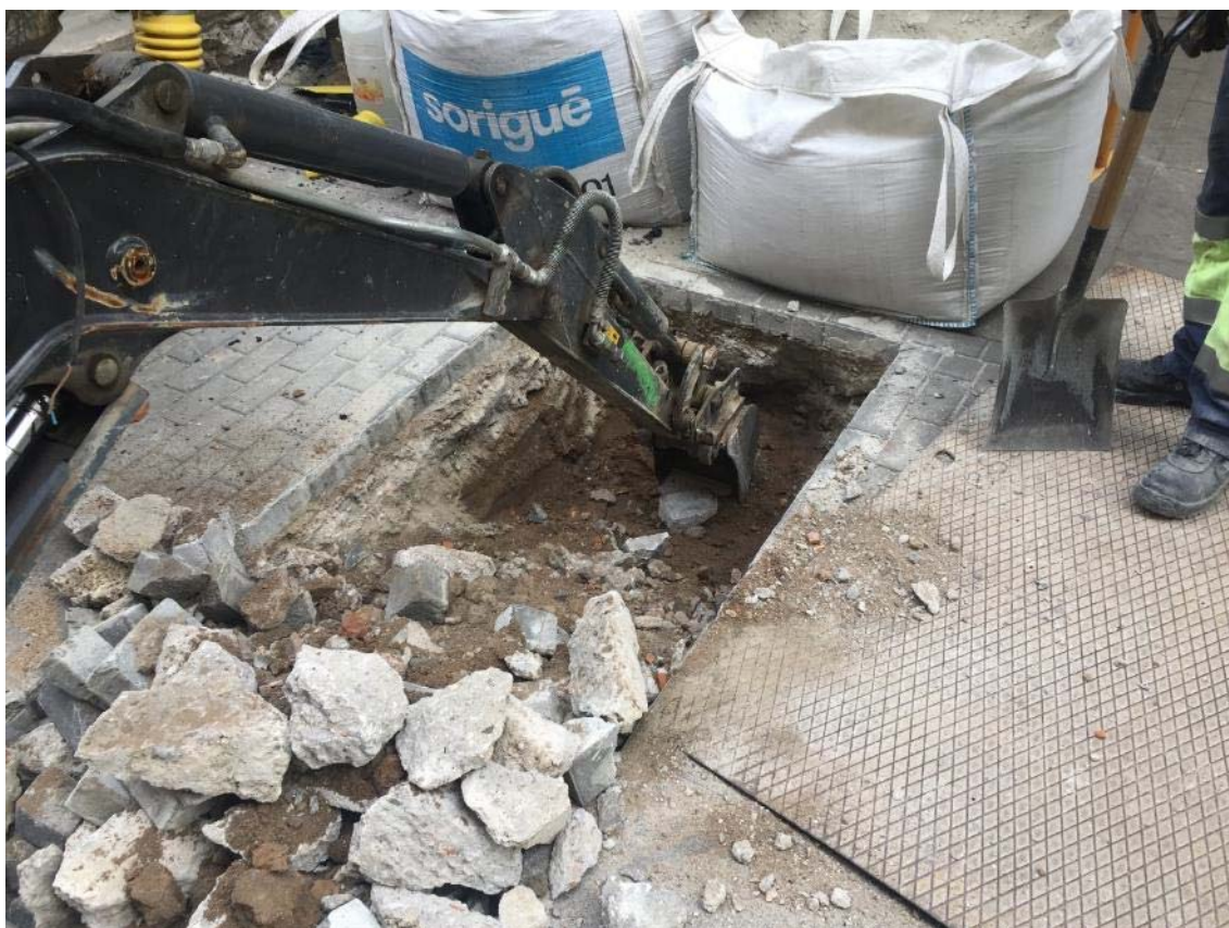
Foto 18: realització de la rasa 2.
