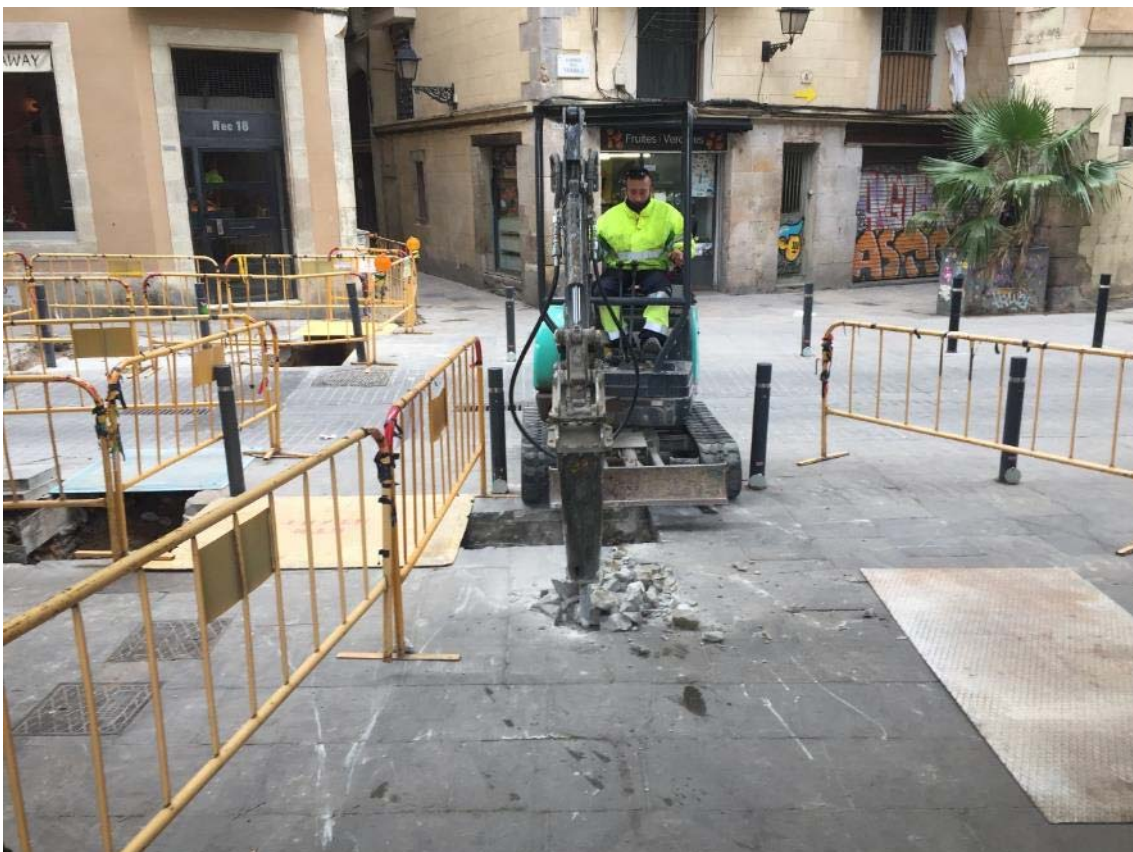
Foto 25: realització de la rasa 5.
