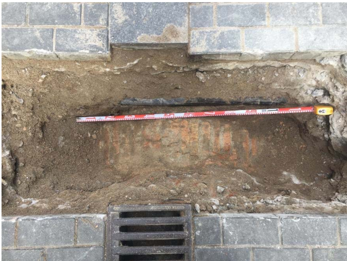
Foto 17: volta de claveguera feta a partir de totxana.
