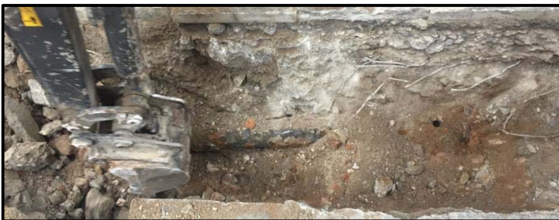
Foto 5: localització del servei d'aigua en desús que va paral·lel a la rasa del carrer de la Fusina.
