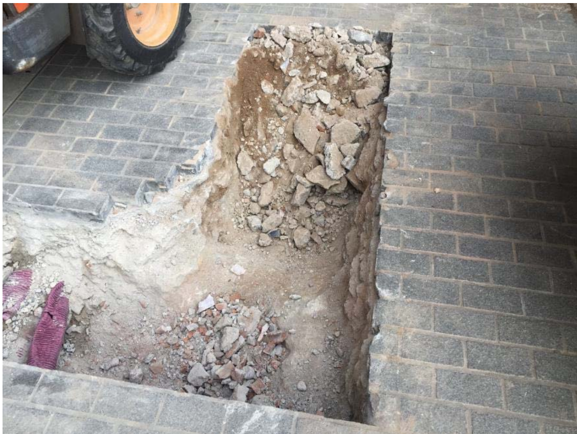
Foto 36: final de la rasa 5 (carrer de la Fusina), lloc on va a parar el cablejat.
