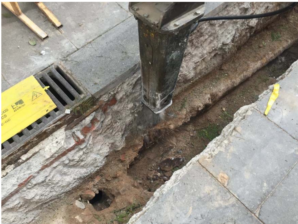
Foto 37: extracció de part del servei en desús.
