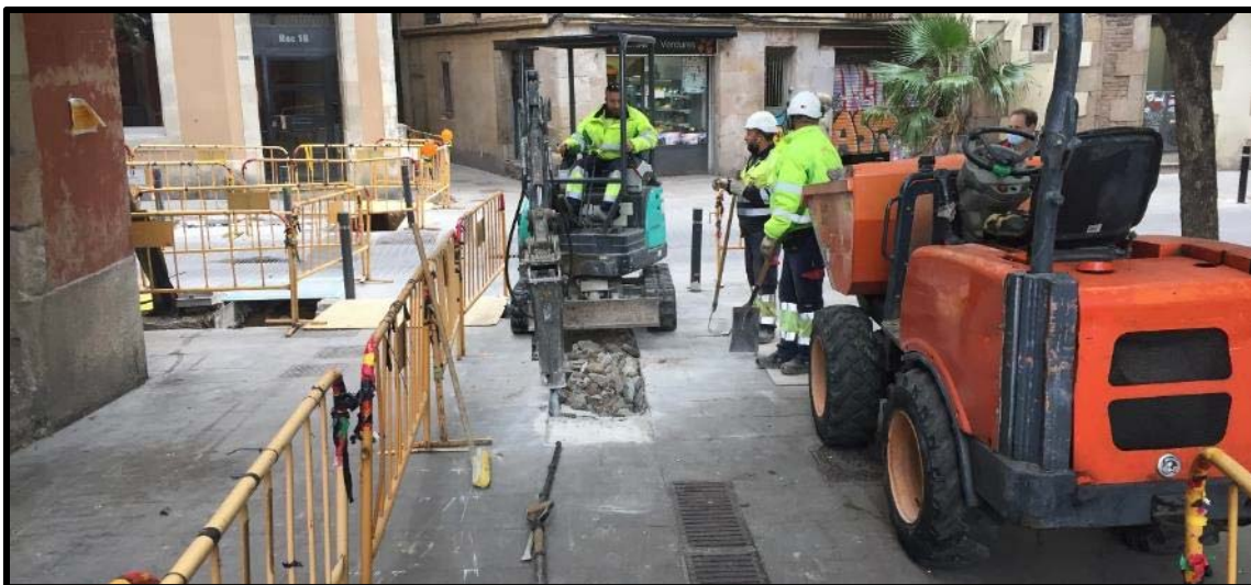
Foto 4: començament de la rasa del carrer de la Fusina.
