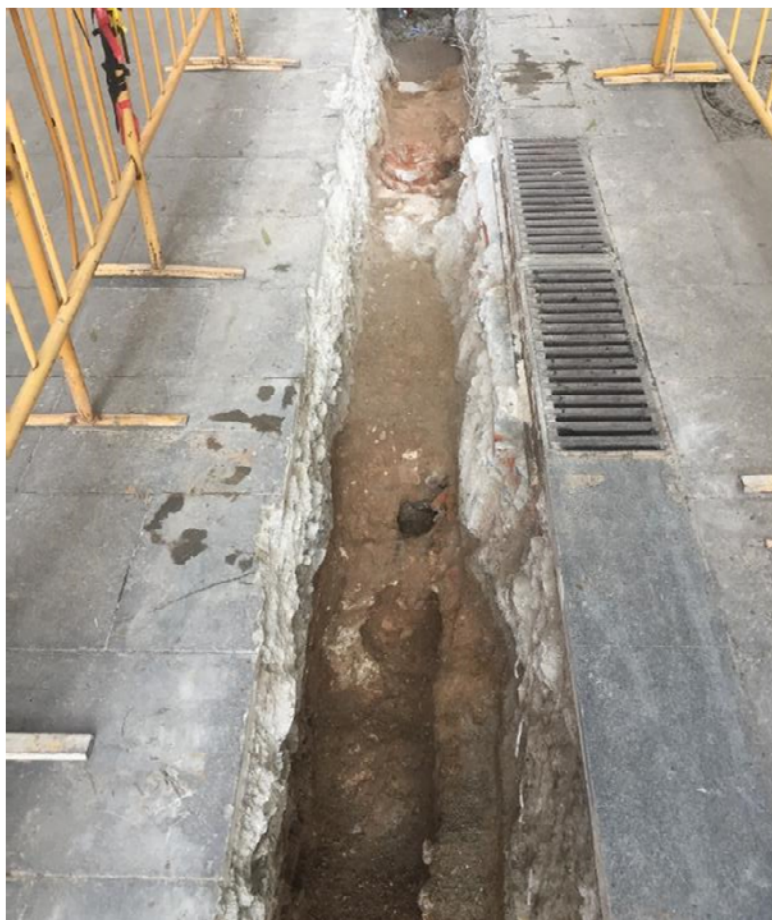
Foto 33: vista de la coberta del rec.
