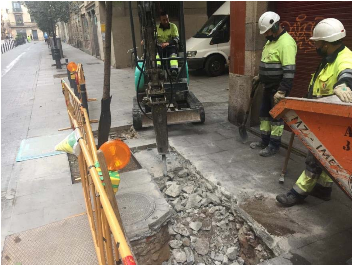
Foto 22: realització de la rasa 4.
