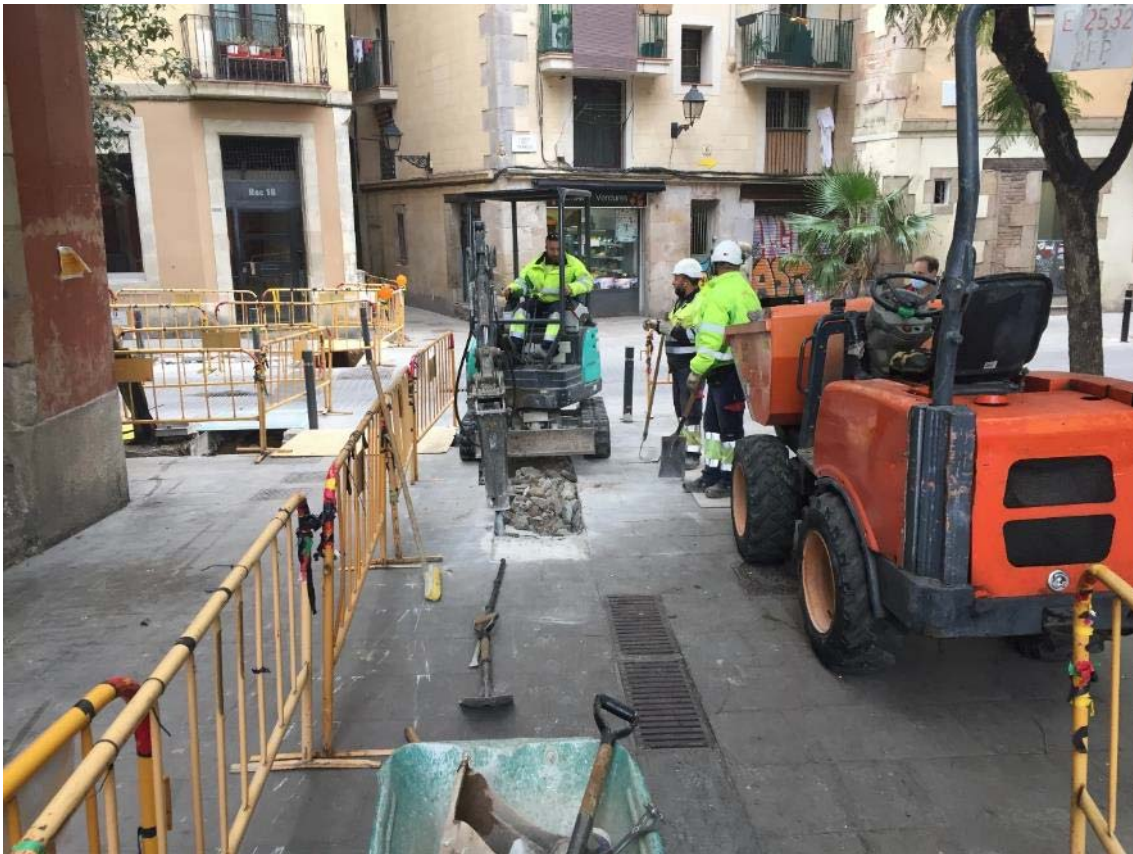
Foto 26: realització de la rasa 5.
