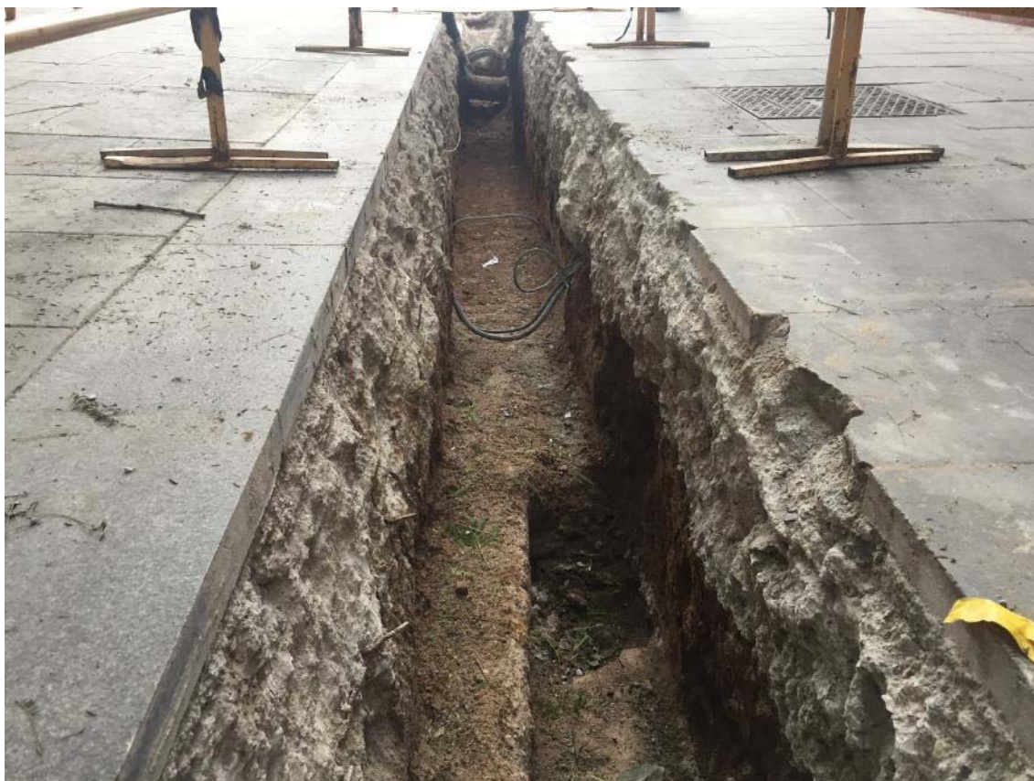
Foto 34: vista del final de la rasa 5 (carrer de la Fusina).
