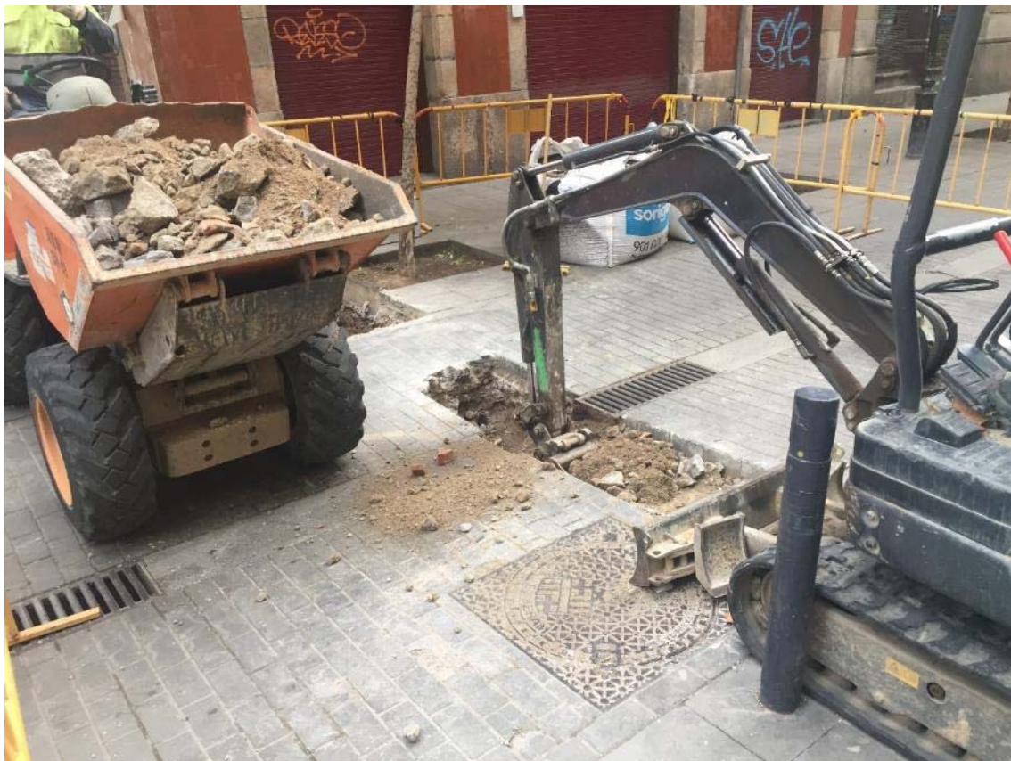
Foto 14: realització de la rasa 1.
