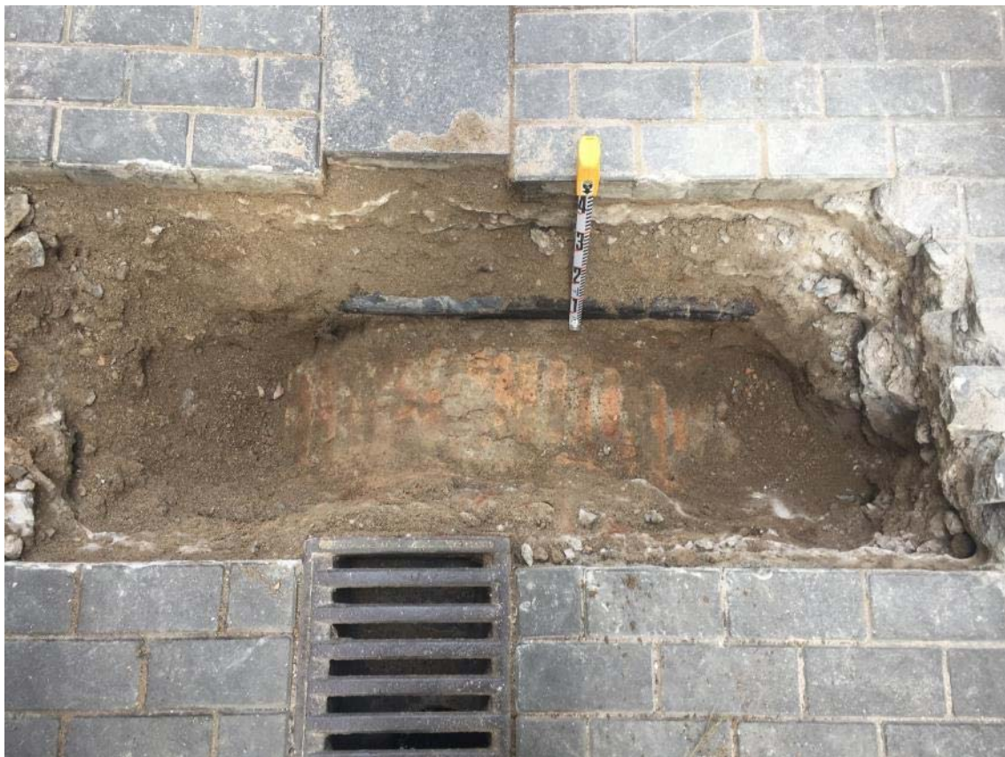
Foto 16: volta de claveguera feta a partir de totxana.
