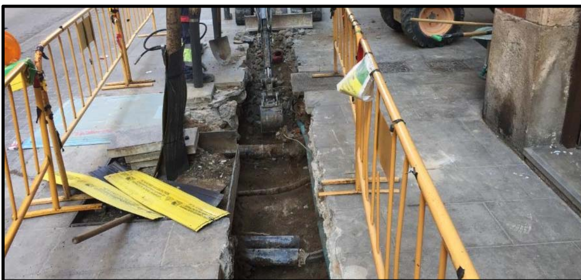
Foto 3: rasa 4. Es pot observar la gran quantitat de serveis que creuen la rasa.
