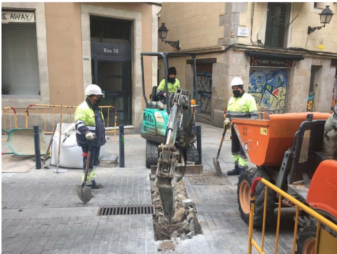
Foto 13: realització de la rasa 1.
