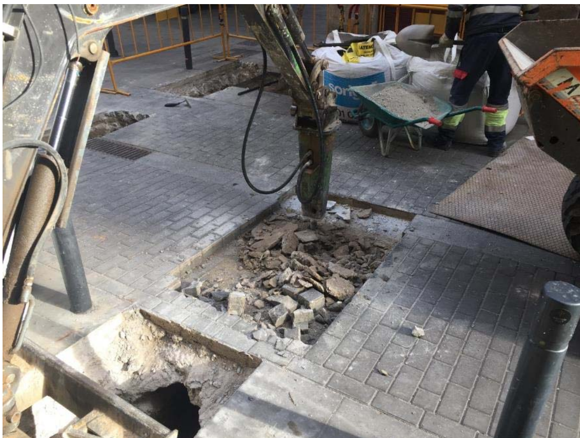
Foto 17: realització de la rasa 2.
