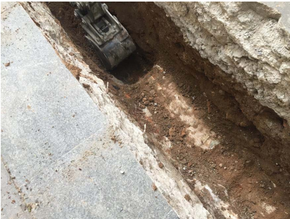
Foto 38: excavació del lateral del rec per poder documentar part de la paret.
