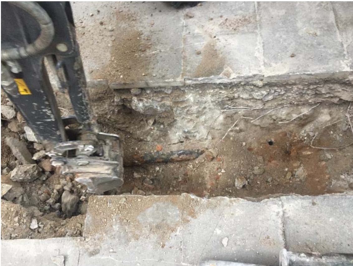
Foto 27: realització de la rasa 5. Troballa d'un servei en desús.
